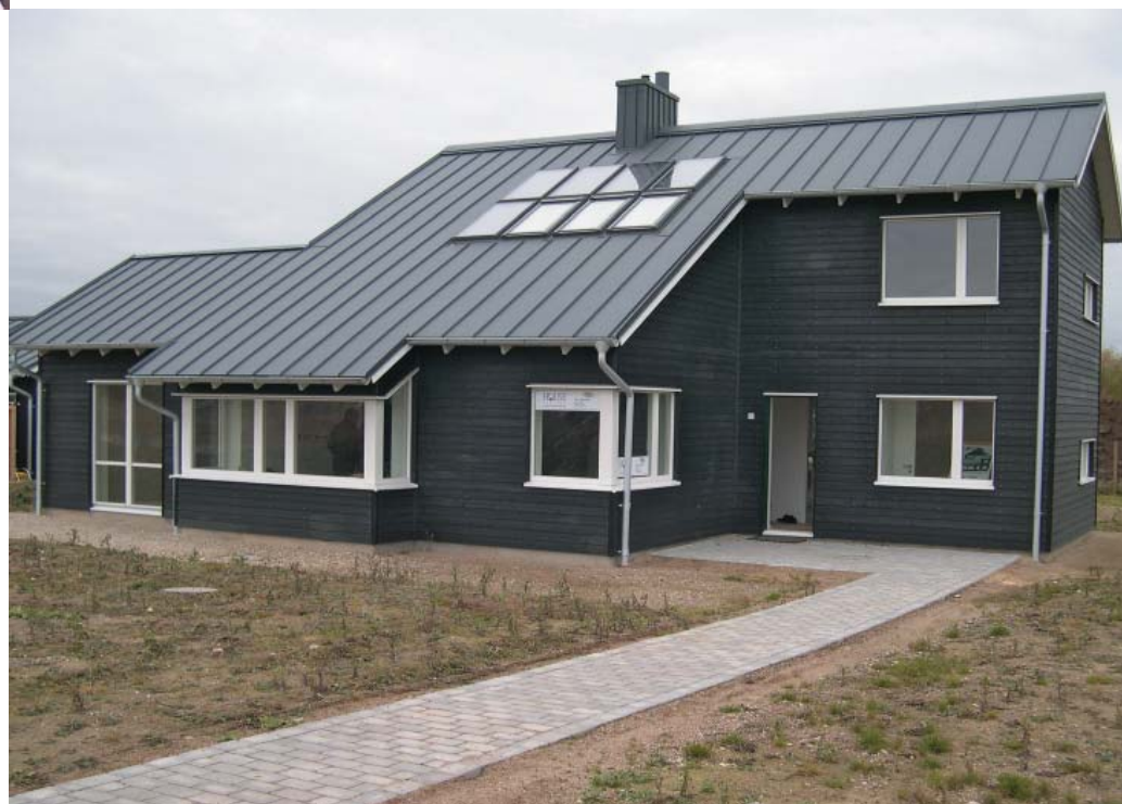
Energiklasse 1 parcelhus fra AA huse. Opført i Herfølge 2007-8. Foto: Torben Valdbjørn Rasmussen, SBI, AAU.
