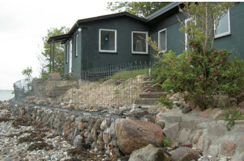
Sikring af sommerhus på Nekselø. Foto: Bent Andersen.
